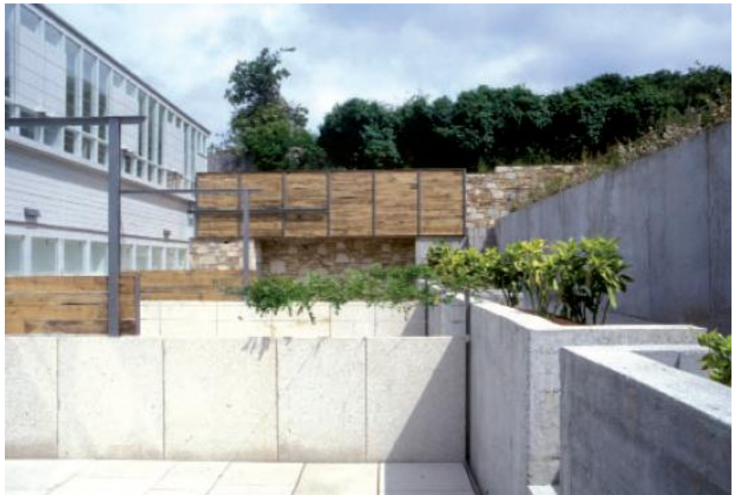
La Vaquería. Promotor Otero Pombo Arquitectos: Víctor López Cotelo y José Manuel Vargas Funes
